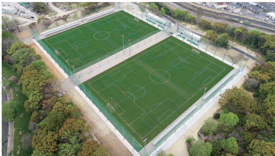
四日市市中央フットボール場 B フィールド・C フィールド（三重県）
