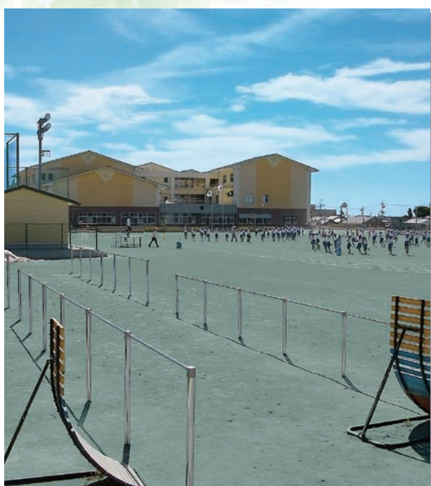
浜松市立雄踏小学校グラウンド（静岡県）
