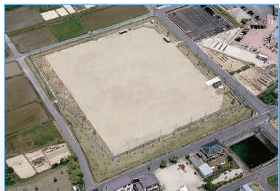
▲ 大府市石ヶ瀬多目的グラウンド
