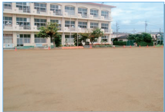
▲ 木曽岬町立木曽岬小学校グラウンド(三重県)
