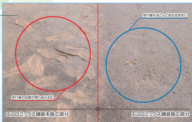
降雨後1時間程度経過した状態のエコロミックス混合土の状況
